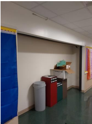
002092a 1/9/2023 Roll-up overhead door Room 1202
