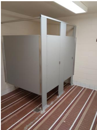
009009a 1/10/2023 Toilet partitions Room OA381
