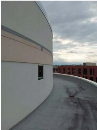
001007a 1/12/2023 Rotunda EIFS wall Rotunda roof
