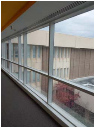
001048a 1/12/2023 Curtainwall Room 3085
