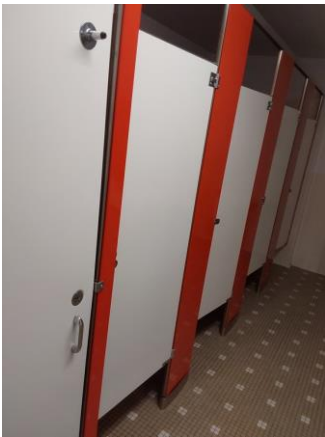
033069a 1/10/2023 Toilet partitions Room 108
